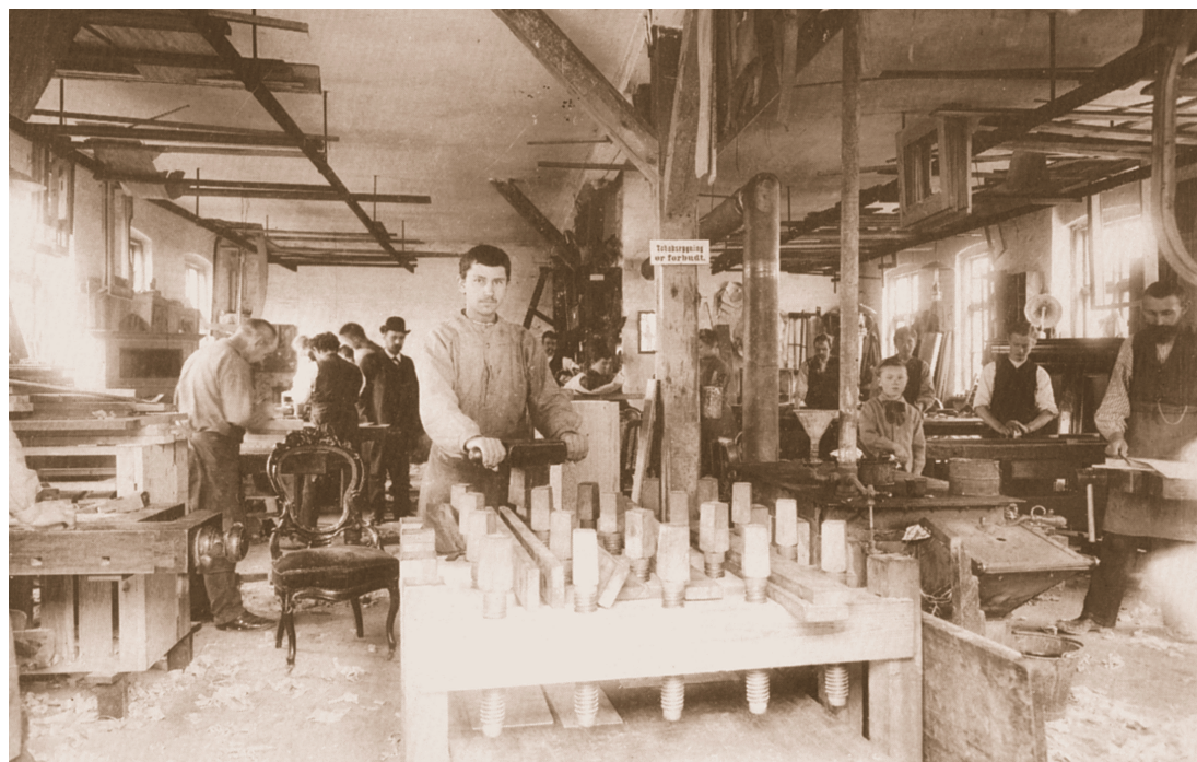
På Jørgen C. Nielsens værksted i 1908 gik svendene klædt i skjorte og vest. Hele fire svende ses til højre ved deres høvlebænke. Finérovnen kørte hele dagen og læredrengen i forgrunden står ved finéplassen og limer finér på plade. Mester står bagerst med bowleren. Se værkstedsordenen på næste side.
